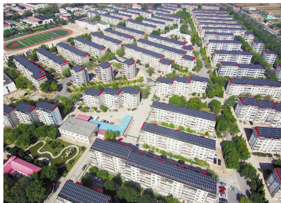
大港油田港狮小区民用建筑光伏一体化项目。
