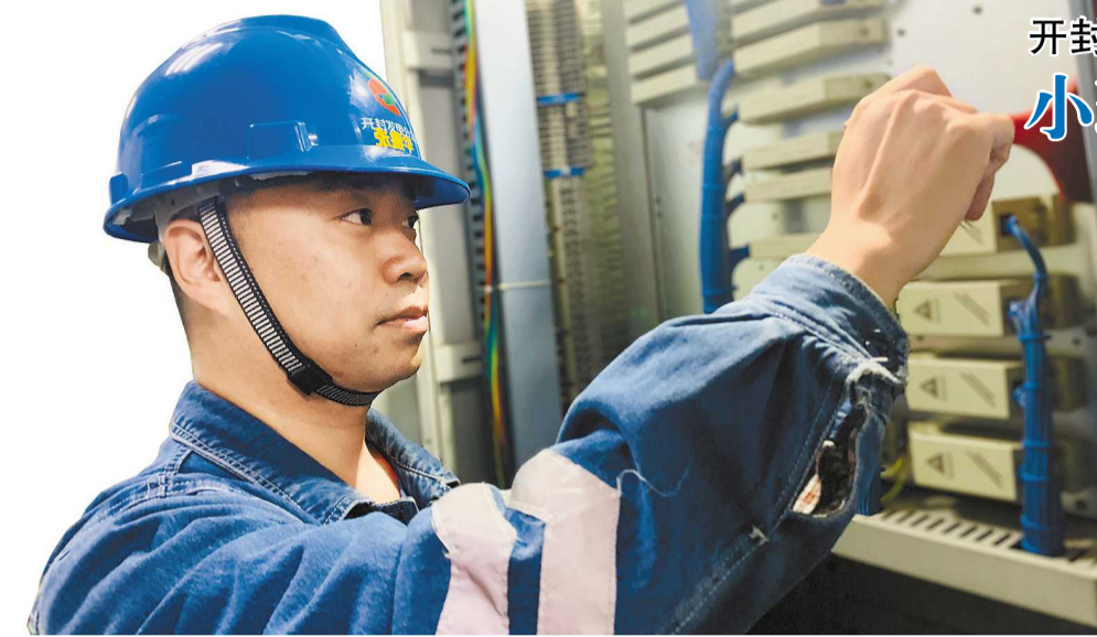
开封发电维护部电气二班张振华在清扫发电机保护柜端子排
