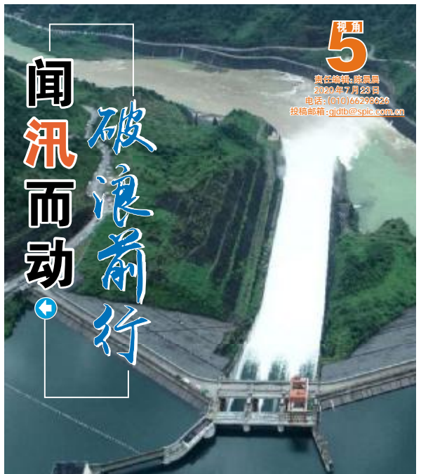
三板溪水电站溢流 黄飞摄
